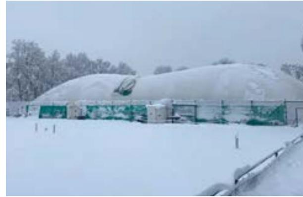
Am Samstag, 2.12., wurde die Halle aus Sicherheitsgründen um 11 Uhr gesperrt. Die Schneemassen auf dem Hallendach drückten die Hallendecke erheblich nach unten, so dass ein sicherer Hallenbetrieb nicht mehr gewährleistet werden konnte.
